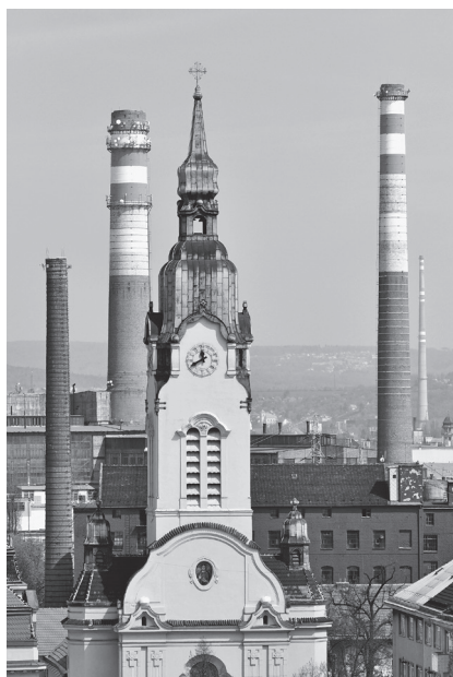
Obr. 3 Nejvyšší zděné komíny v Brně patří místní teplárně Na Špitálce (bývalá ZME) – nejstarším komínem v areálu je komín vpravo, 2010 (fotoarchiv autora)
