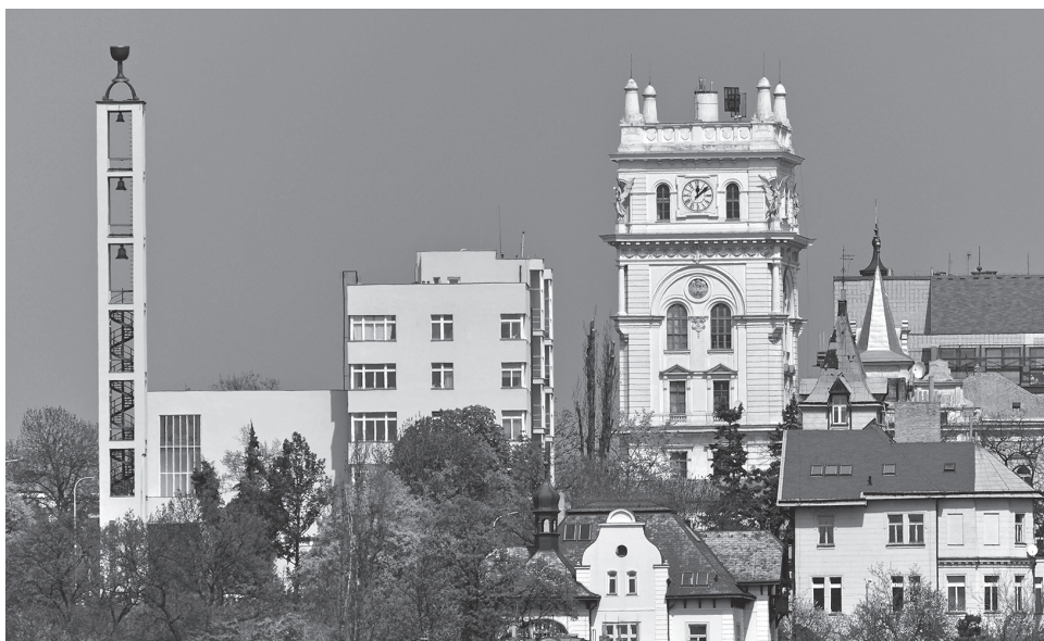
Obr. 4 Neorenesanční věžový vodojem na Vinohradech a jeho zamaskovaný komín umístěný v ose věže, 2010 (fotoarchiv autora)
